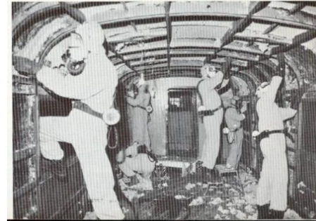
Scobentazione dell'amianto spruzzato in carrozze ferroviarie in uno stabilimento padovano. Anni '80. (foto fascicolo processuale)
